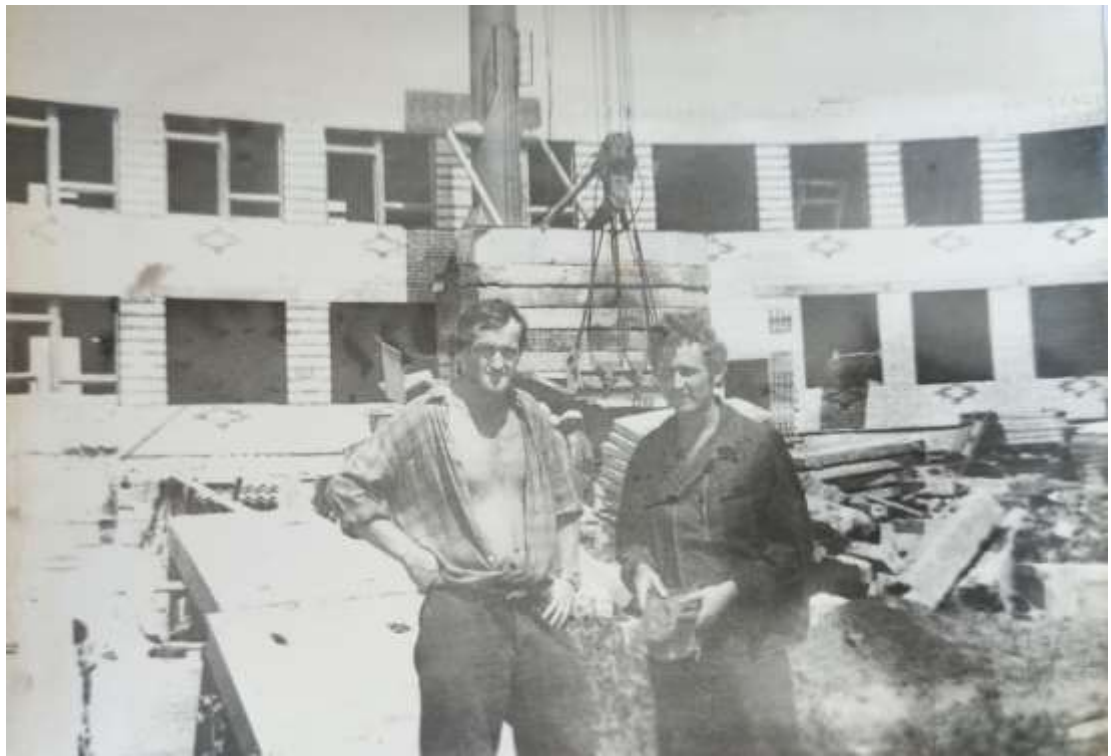
Строительство школы Кожухов Н. и Авдошин Ю.
