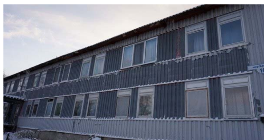
Рисунок 3 – Сборно-разборные щитовые дома в поселке Берлин
