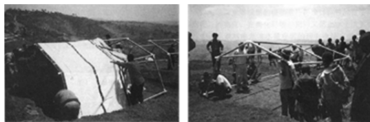
Рисунок 2 – Строительство временного жилья для беженцев
