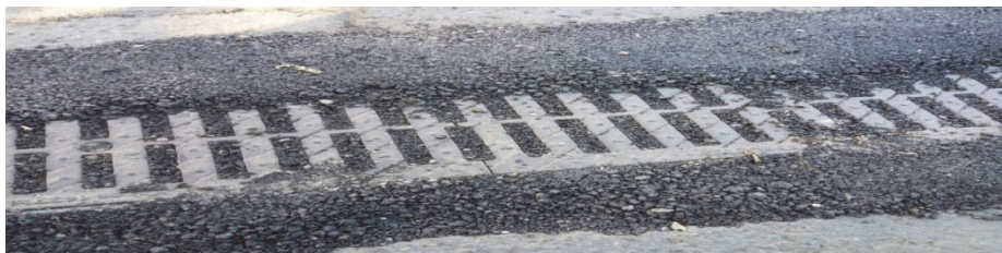
Рисунок 2 - Заасфальтированная решётка ливневой канализации
