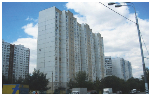
Рисунок 2 – Фасад панельного дома серии П-44
