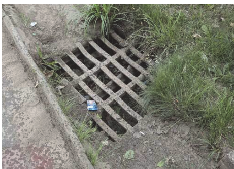
Рисунок 1 - Забитая мусором ливневая канализация
