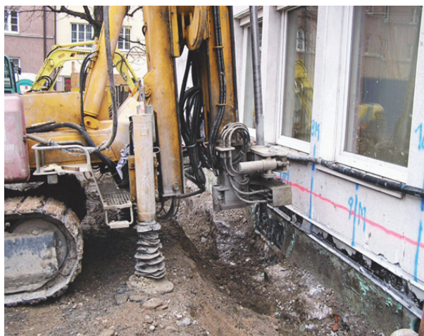
Рисунок 3 - Пример применения технологии Jet grouting
