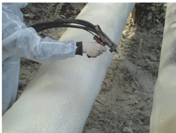
Рисунок 1- Распыление жидкого пенополиуретана
