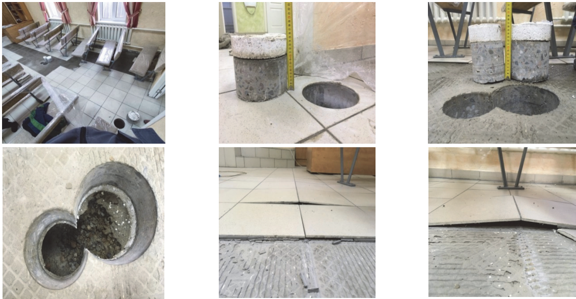
Рисунок 4- Фотоматериалы деформаций пола
