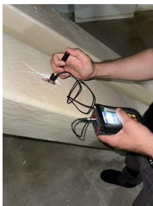
Фото Ж.2 – Проведение контроля по определению твердости элементов.
