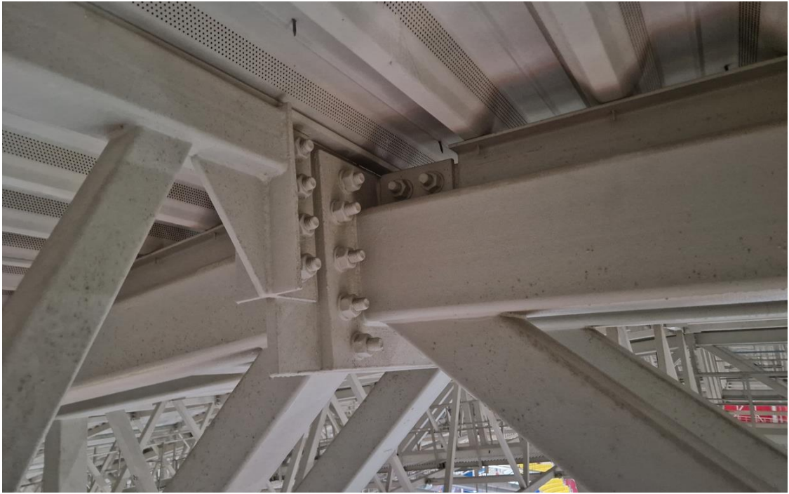
Рисунок 6.5 – Узел сопряжения сегментов верхнего пояса арки и крепления вертикальной связи П1.
