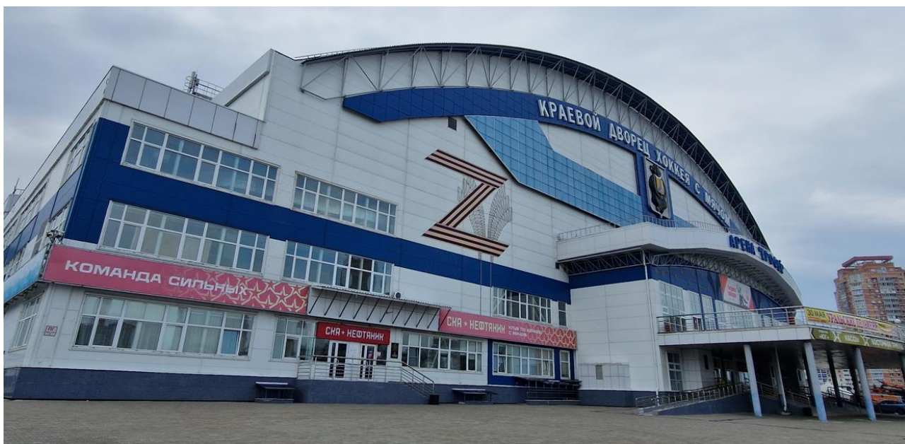
Рисунок 6.2 – Общее фото здания со стороны фасада Т-А.
