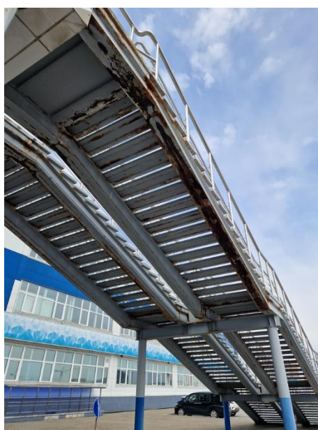
Рисунок 6.9 – Общее фото наружной лестницы со стороны фасада 14-1.
