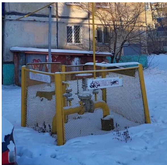
Рисунок 6 – Газовая подстанция
