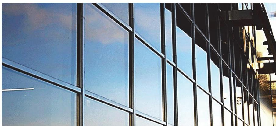
Рис. 2. Закрытая классическая система фасадного остекления
