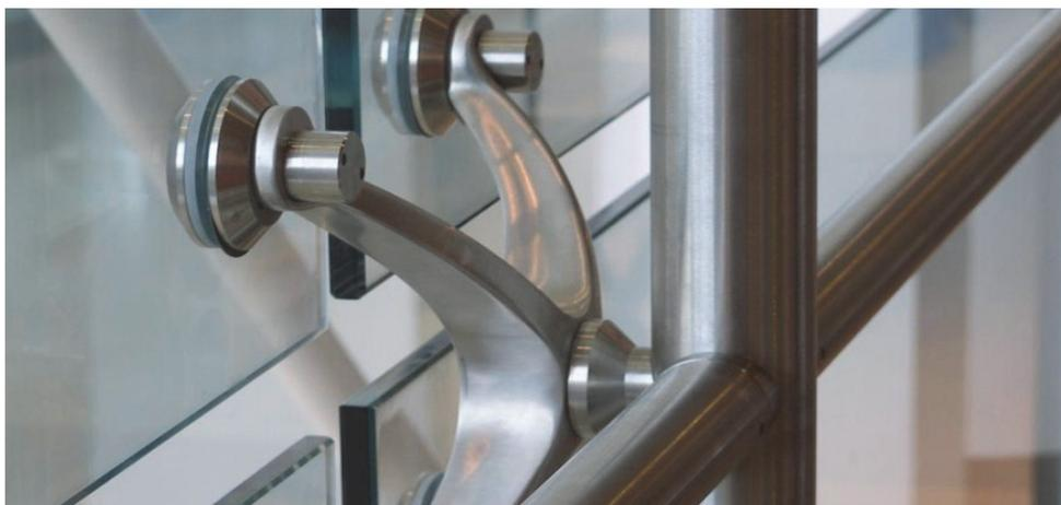
Рис. 6. Система крепления спайдерной системы
