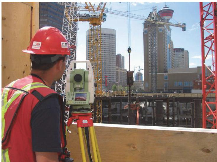
Рис. 1. Процесс геодезического контроля
