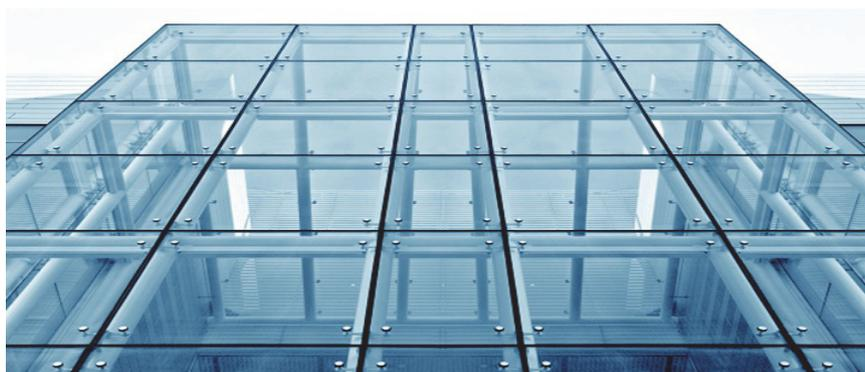
Рис. 5. Спайдерные конструкции фасадного остекления
