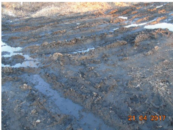
Рис. 2. Размыв дороги в результате оттаивания глинистого грунта
