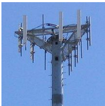
Рисунок 7 - Антенны трех базовых станций на мачте
