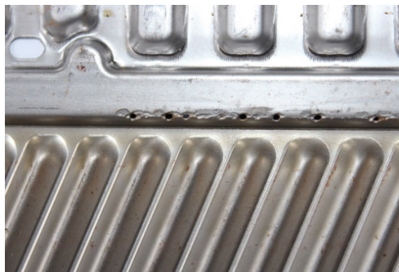
Рисунок 2 – Точечная коррозия на пластинах теплообменника
